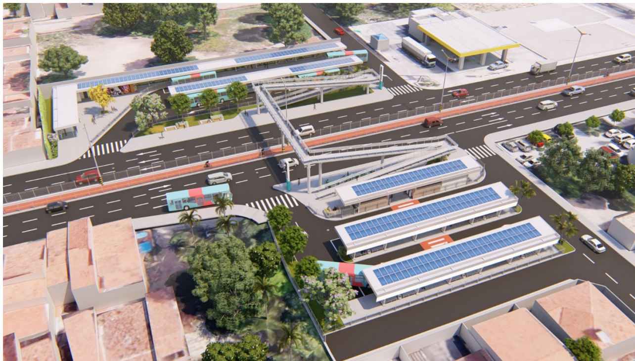
Figura 2 - Vista aérea do projeto
