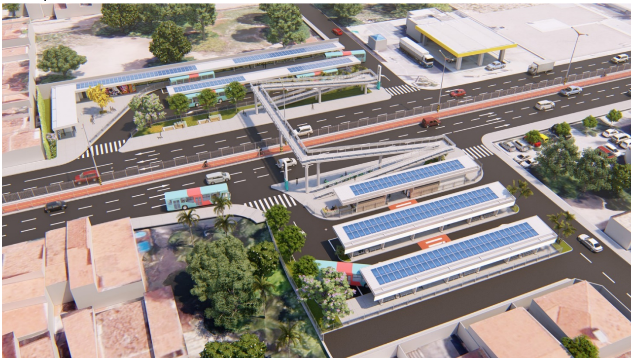
Figura 4 - Vista aérea do projeto
